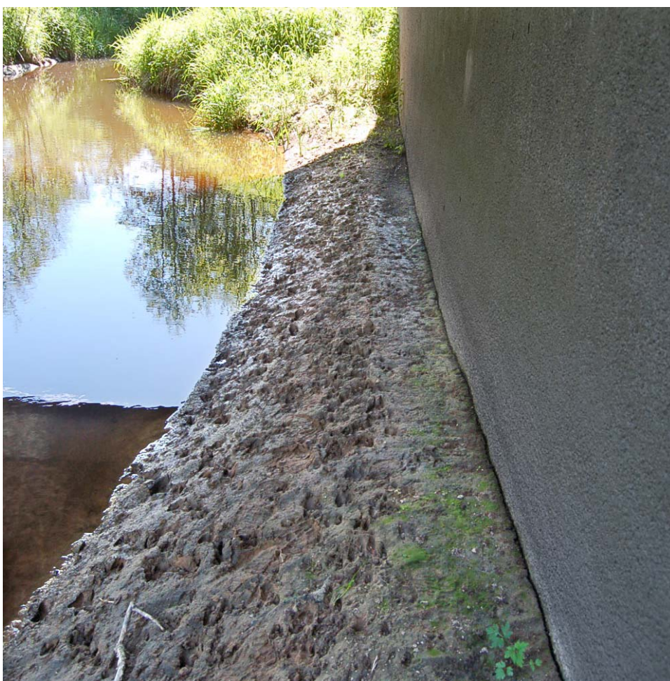
Delsträcka B. På översta bilden syns stamvalvbron strax till vänster. På nedersta bilden syns rikligt med djurspår under befintlig bro.
