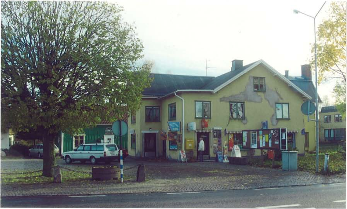
Hova 2:9. Husets nuvarande putsfasad är från 1950-talet, men i stommen bärstammar buset från 1800-talet, tillbyggt i vinkel efter 1900. Från ca 1905 var gästgiveriet inrymt här. Huset har stort värde för bebyggelsemönstret på torgets sydsida, där övriga äldre hus har försvunnit under 1900-talet.
