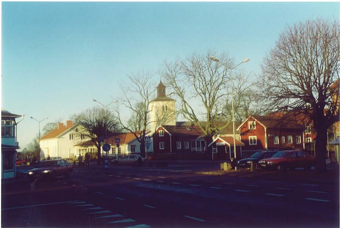
Översikt mot torgets ursprungliga norra del med kyrkan, f.d. Norra Gubbegården och Järpegården m.fl.
