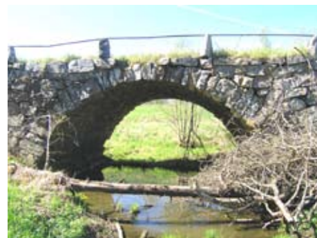
Hovbron är välvd i ett spann, uppförd av tuktad sten i kallmur. På andra platser längs gamla riksvägen/E20 i Västergötland har en så stark historisk förankring i handel och kommunikation mellan Västsverige och Svealand–Mälardalen.
