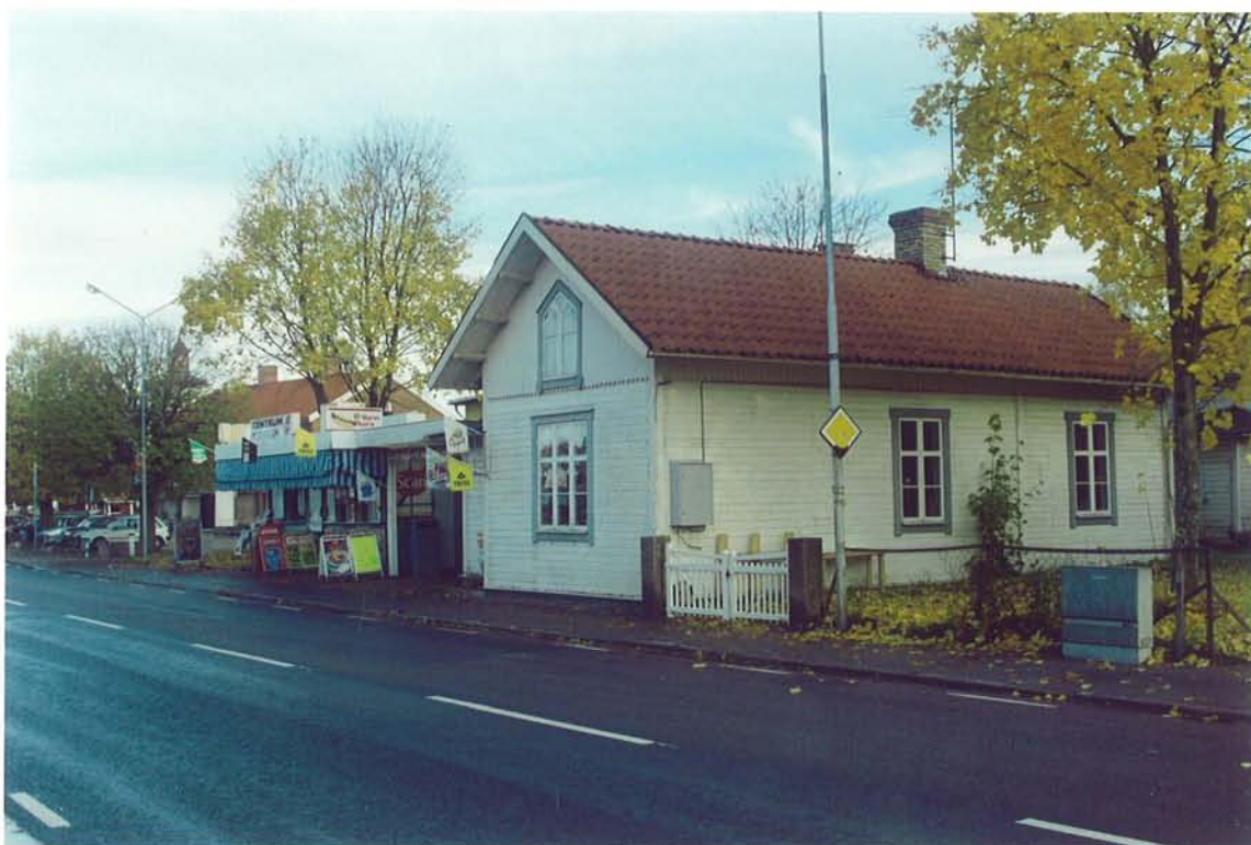
Hova 2:5, Torggatan 17. Det lilla huset vid gatan har en något mer stadsmässig fasadutformning med stildrag från det sena 1800-talets panelarkitektur. Det har inrymt bostad och bl.a. affärslokal för Veramagasinet. Till karaktären av sent 1800-tal – 1900 bidrar även den vita dubbelgrinden i trä.
