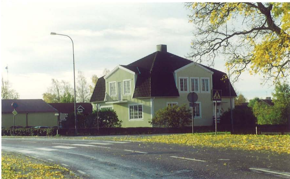
Hova 3:29, Solhäll, Torggatan 4 byggdes 1922 och är utformat som en liten stadsvilla med ljus slätputsad fasad, valmat brutet tak och stora fönster spröjsade med små rutor. Huset har i sen tid fått bl.a. ny typ av taktäckning, men bibehåller till väsentliga delar den tidstypiska villastilen.
