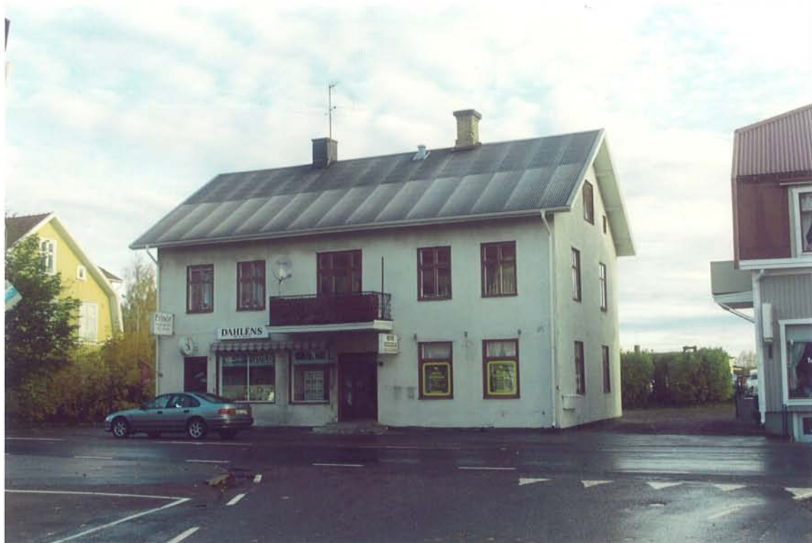
Torggatan 25, Hova 3:52. Bostadshuset från 1912 bibehåller bl.a. slätputsad fasad och på framsidan en troligen ursprunglig balkong i järnsmide. Frånsett taktäckningen med skivor har huset i huvudsak sin äldre karaktär i behåll. 1953 innehöll huset tre bostadslägenheter samt i bottenvåningen lokaler för ett café och en skoaffär. Numera inryms här bl.a. en frisersalong och en pizzeria.
