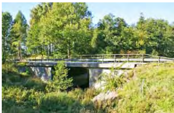
Bild 3.1 Befintlig E 20-bro över Hovaån
