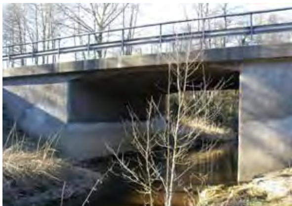
Bild 3.3 Befintlig E 20-bro
