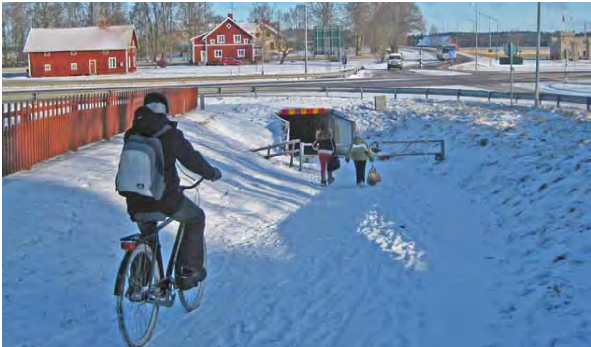
Bild 4.14 Passage under E 20 vid Hova
