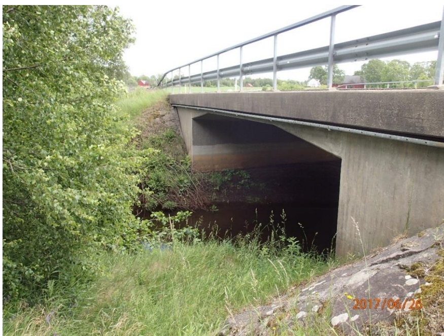
Figur 5. Kåtån vid väg 555 i objekt 3.
