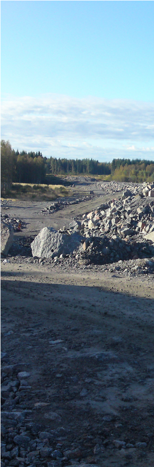
Figur 6.10 Foto påverkan från byggnation nya väg E4, Mörtsjö. 94 Förstudie Gävle - Sundsvall
