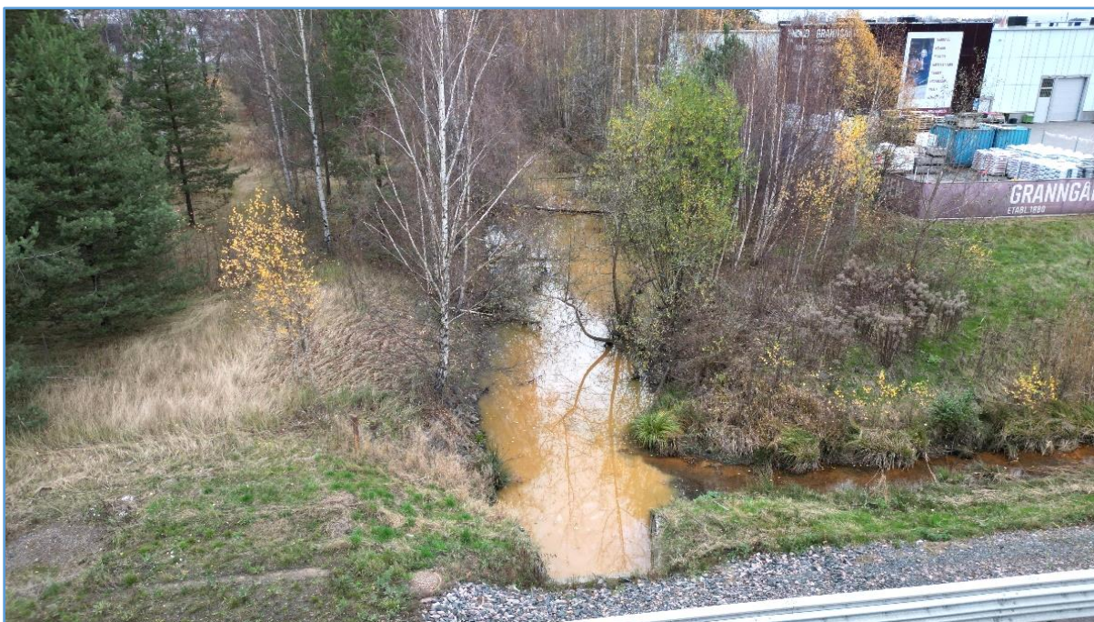
Figur 11. Befintligt dike som är beläget längs den norra sidan av E4/väg 40 och som leder dagvattnet vidare mot Munksjön.
