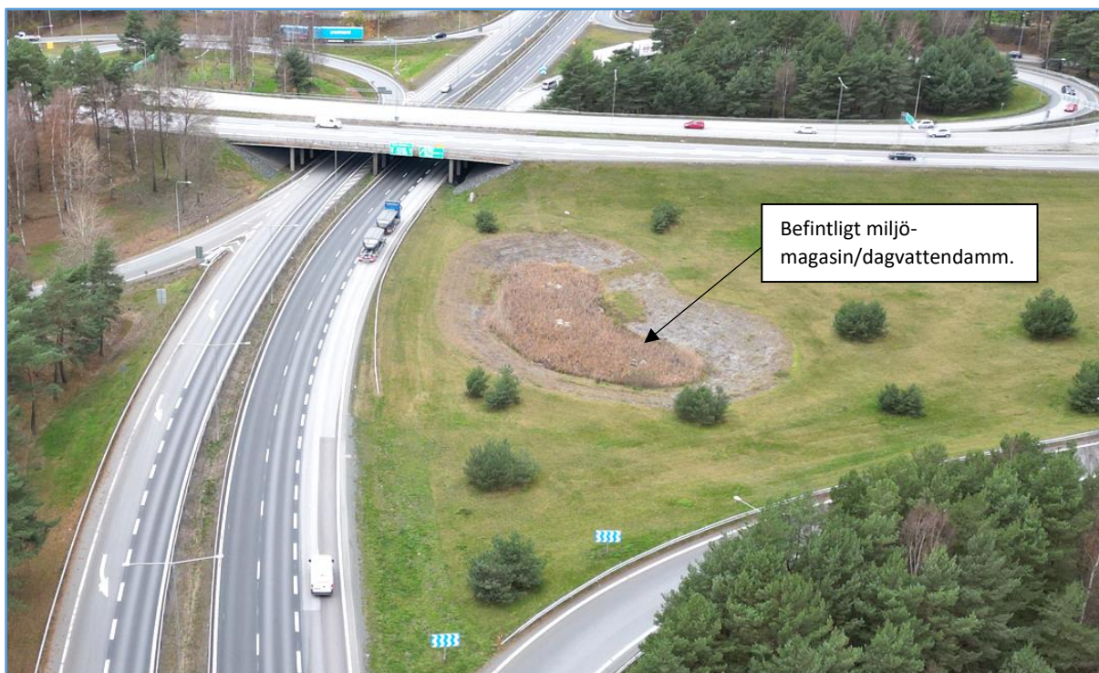
Figur 12. Befintligt miljömagasin/dagvattendamm som är beläget i anslutning till trafikplats Ljungarum.
