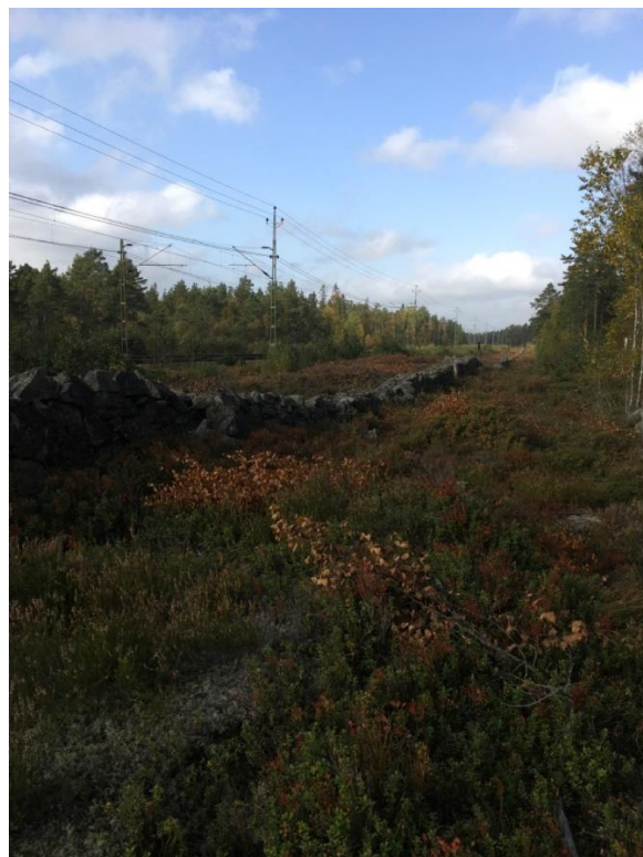
Figur 27. Naturvärdesobjekt 13. Brandmur norr om järnväg, foto taget mot sydväst.
