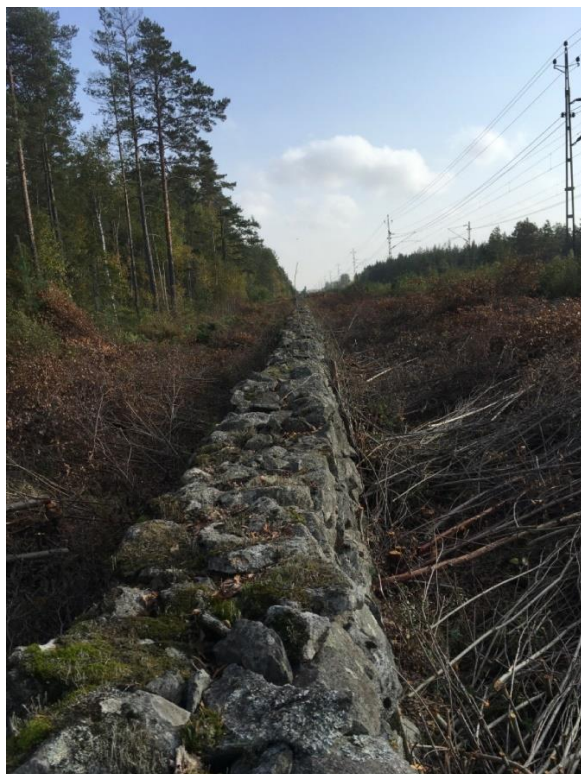
Figur 26 Naturvärdesobjekt 13. Brandmur norr om järnväg, foto taget mot sydöst.
