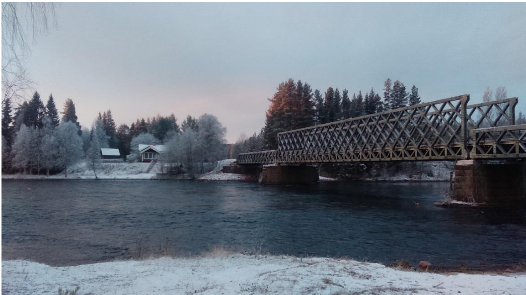
Figur 4.2. Bild på sommarbostaden och den tillfälliga järnvägsbron sett söder ifrån.
