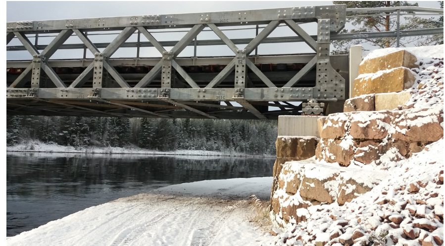
Bilden visar befintlig ersättningsbron med brofästen från den gamla järnvägsbron.
