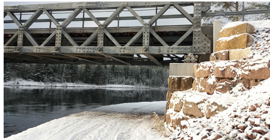
Vägen och järnvägens barriäreffekt vid passagen över Österdalälven minimeras genom att skapa passager under broarna.
