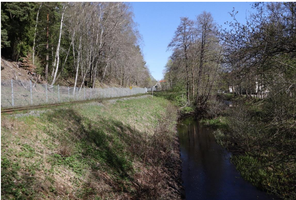
Figur 2 Järnvägen parallellt med Tabergsånen i Taberg. Foto: Trafikverket
