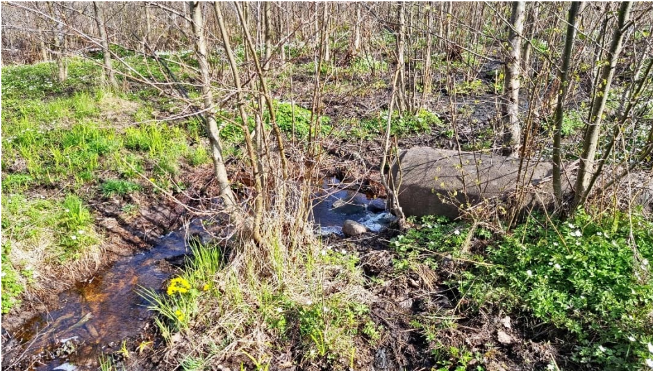
Foto 3. Utloppet av kulverten på den västra sidan ner mot Kalvsjön.
