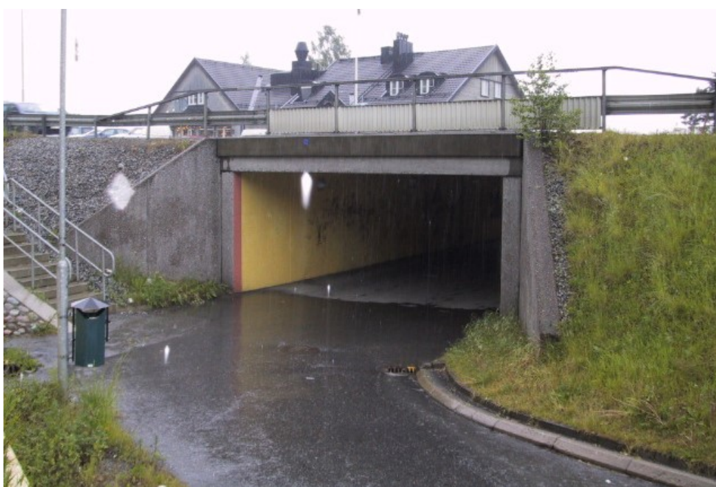
Figur 5. Befintlig Bro över gång- och cykelväg vid Grisslinge Vårdshus. Foto taget norr om väg 222 med riktning söderut. Foto från broförvaltningssystemet BaTMan.
