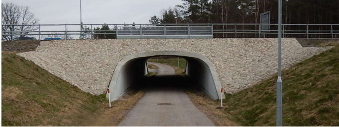
Figur 4. Gång- och cykelport utformad som valvbåge av stål (foto: BaTMan /Trafikverket).
