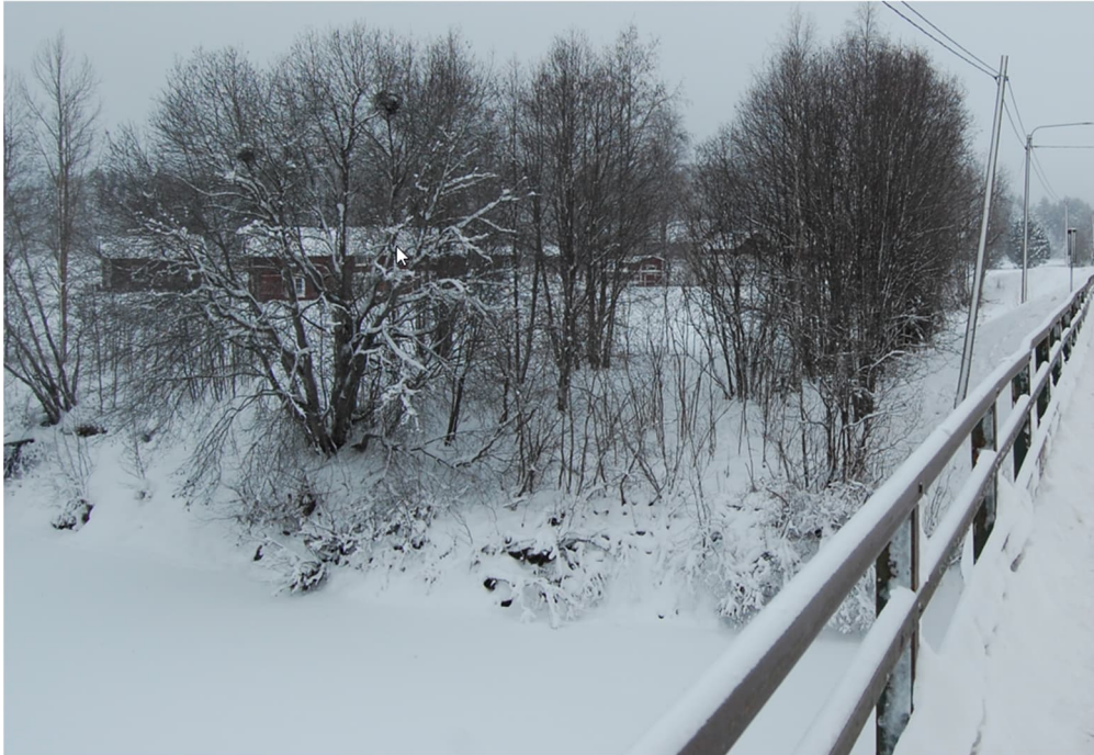
Figur 8. Landskapsbild uppströms över Öreälven, norra sidan där den tillfälliga överfarten ska anläggas.
