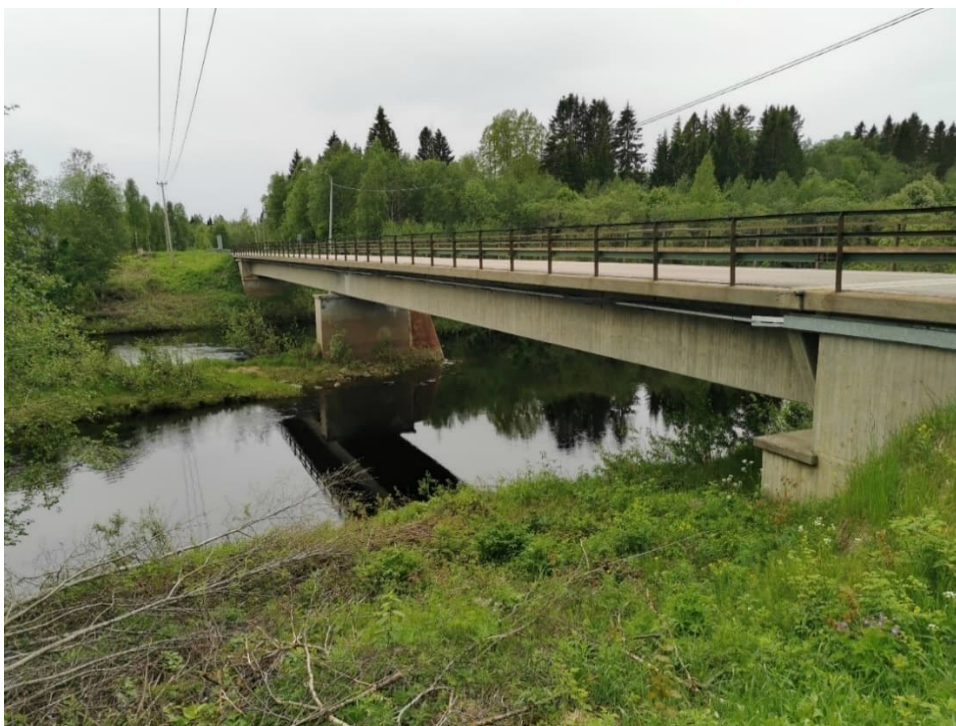
Figur 6. Befintligt bro 24-502-1 sedd från nedströms vy.
