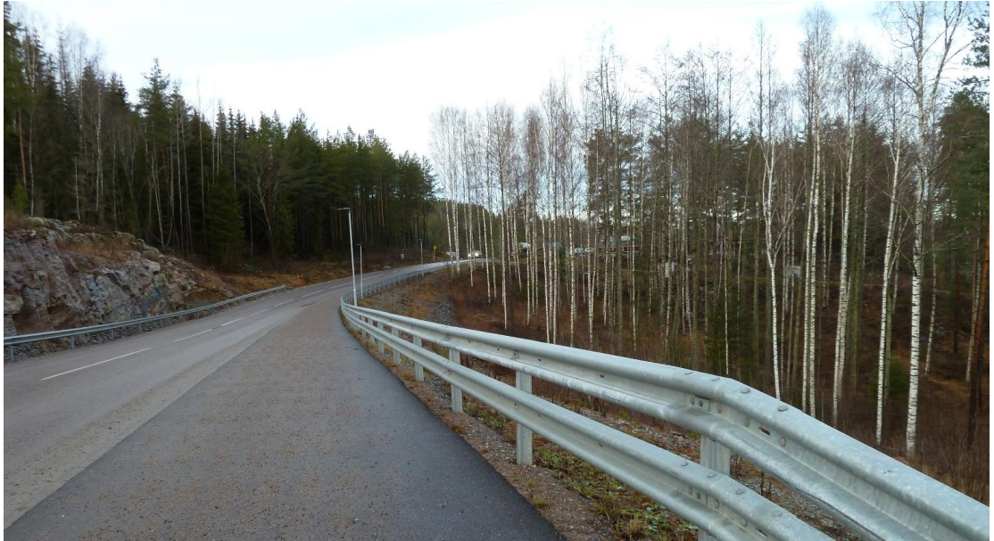
Figur 28. Exempel på förhöjt vägräcke.
