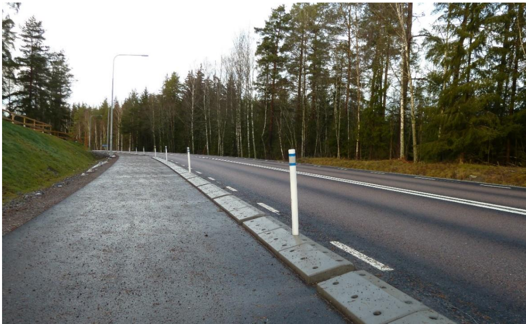
Figur 24. Pollare med reflexer används vid GCM-stöd för att markera trafiksepareringen och öka trafiksäkerheten.
