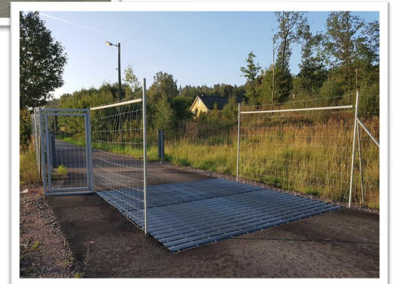
Färist med gånggrind
