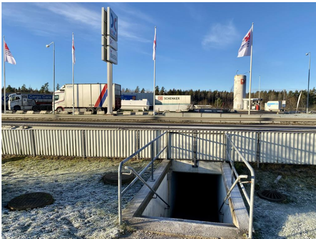
Figur 3. Bild på befintlig passage under E20
