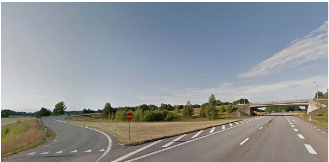
Bild 4.1.1:3 Befintlig E20 vid trafikplats Ullervad
