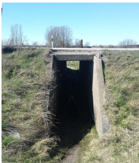
Bild 4.2.5:1 Koport vid Hasslerör, används av barn för att korsa E20
