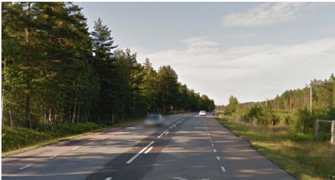
Bild 4.1.1:1 Befintlig E20 söder om trafikplats Brodderud
