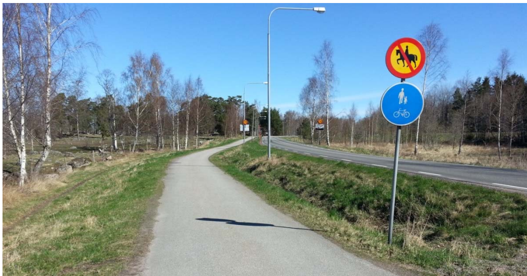
Bild 6.5.5:1 Gång- och cykelvägen mellan Mariestad och Ullervad Tidän.
