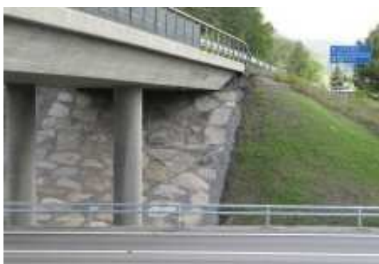
Figur 13. Stenläggning av ordnad sprängsten i grus.
