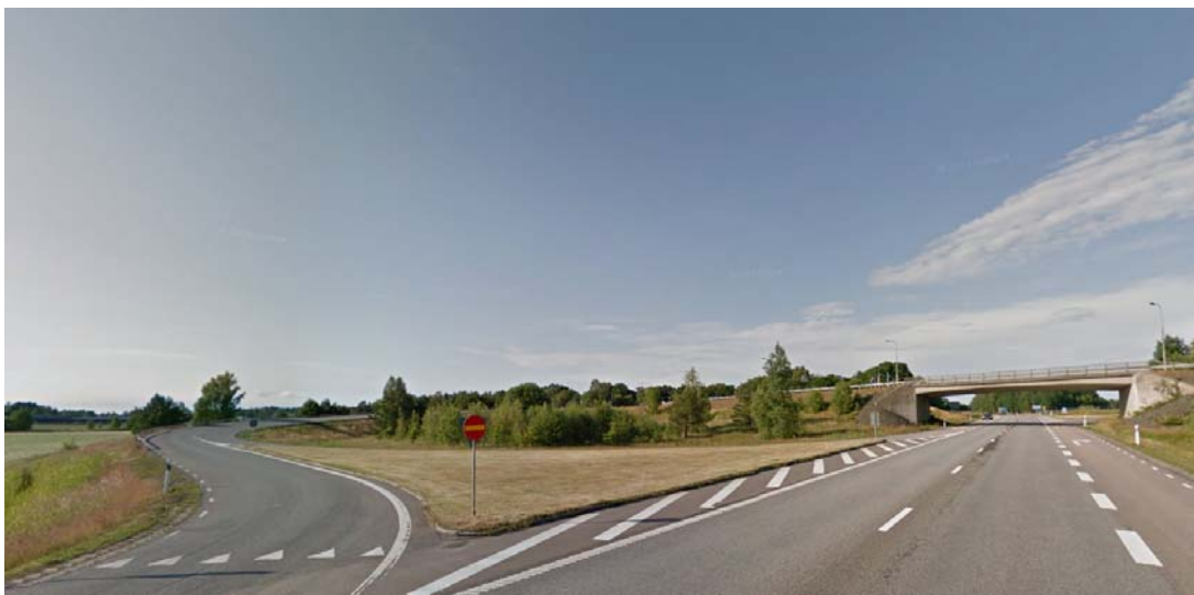
Bild 4.1.1:3 Befintlig E20 vid trafikplats Ullervad
