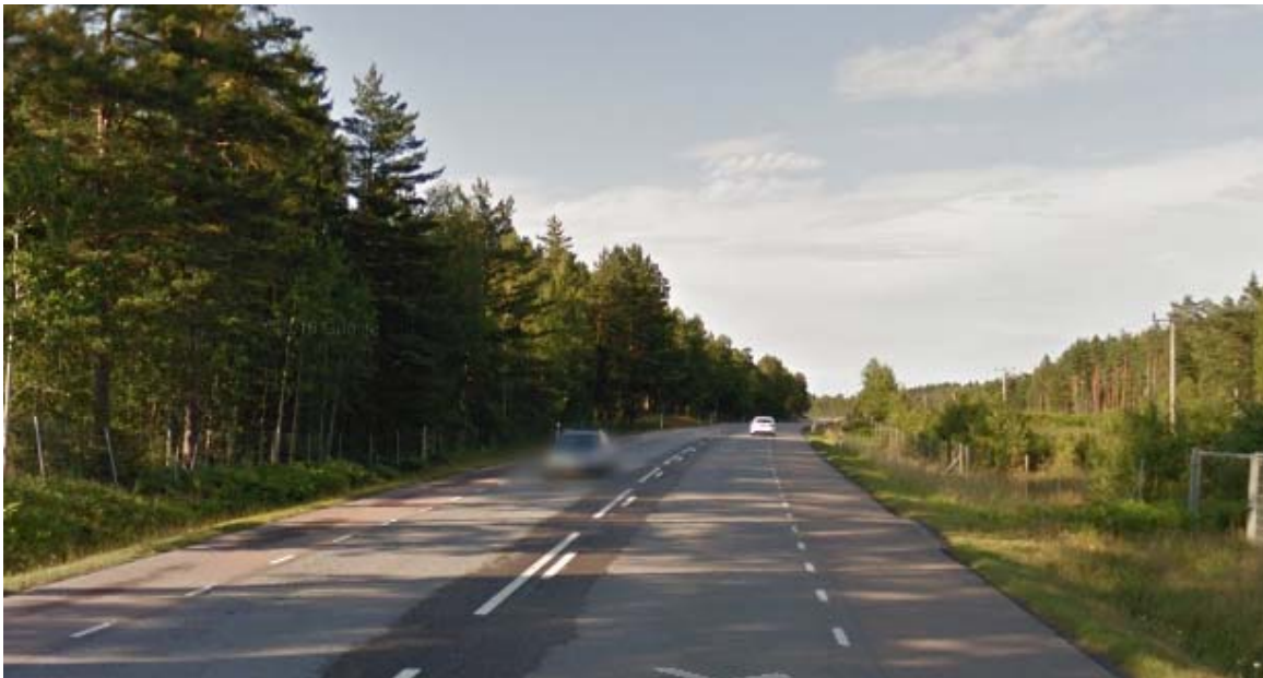
Bild 4.1.1:1 Befintlig E20 söder om trafikplats Brodderud
