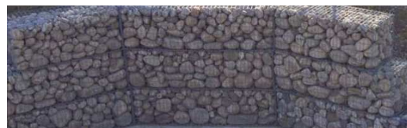
Figur 10. Exempel på gabionmur utförd av kullersten.
