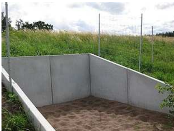
Figur 9. Illustration av funktionen viltuthopp.
