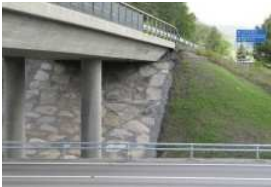
Figur 14. Stenläggning av ordnad sprängsten i grus.
