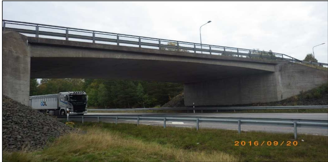
Figur 20. Bro över E20 vid trafikplats Ullervad (Trafikverkets förvaltningssystem för byggnadsverk, BatMan).
