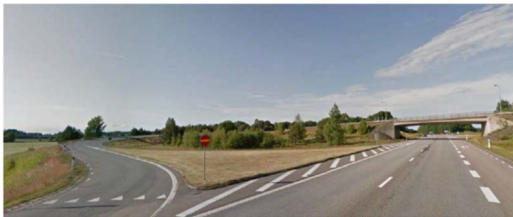
Figur 9. Befintlig E20 vid trafikplats Ullervad (Från Samrådshandling - Val av lokaliseringsalternativ).
