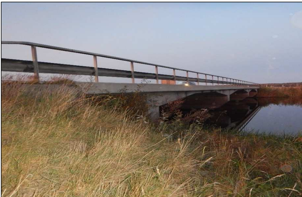
Figur 19. Bro över Tidan (Trafikverkets förvaltningssystem för byggnadsverk, BatMan).
