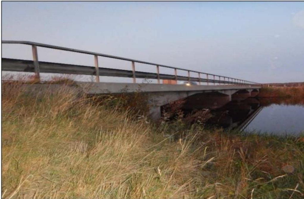
Figur 3. Befintlig bro över Tidan byggd 1958 (Batman)
