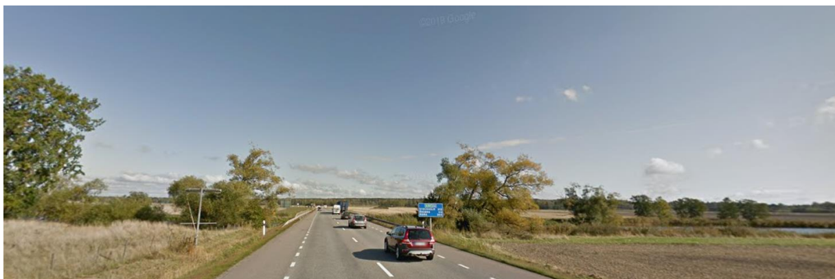
Figur 7. Broläget med omnejd från väster. Ny bro anläggs till höger i bild. Bildinsamling: september 2019, © 2020 Google Sverige, https://goo.gl/maps/UvDEKGD6dRjcZo66 .
