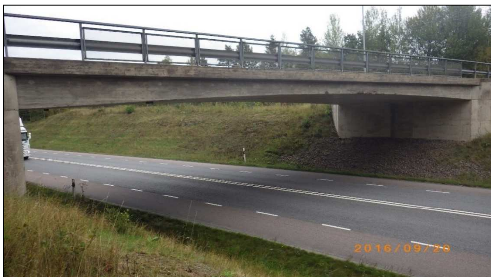
Figur 21 Bro över E20 vid trafikplats Brodderud (Trafikverkets förvaltningssystem för byggnadsverk, BatMan).
