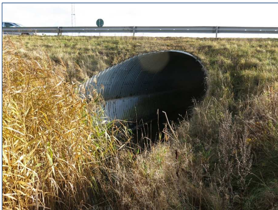
Figur 23 Bro över Hasslebäcken (Trafikverkets förvaltningssystem för byggnadsverk, BatMan).
