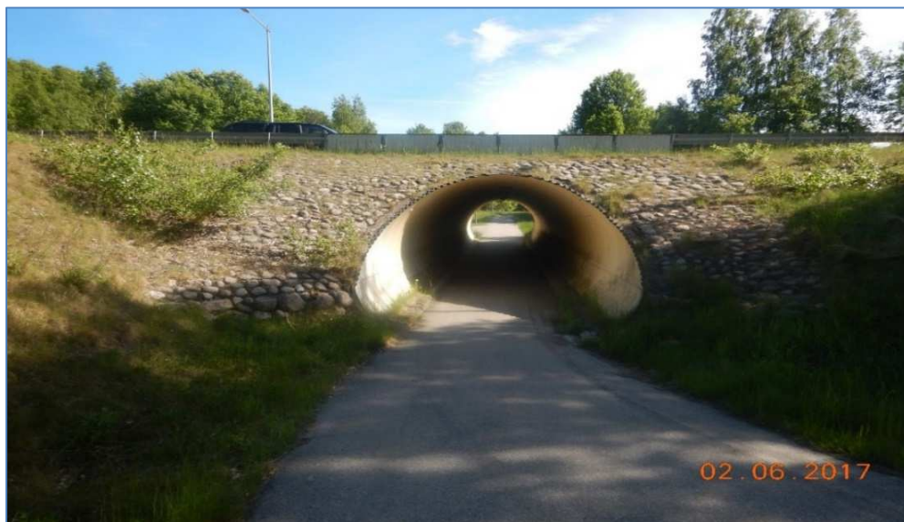
Figur 22 Bro över gång- och cykelväg vid Hasslerör (Trafikverkets förvaltningssystem för byggnadsverk, BatMan).
