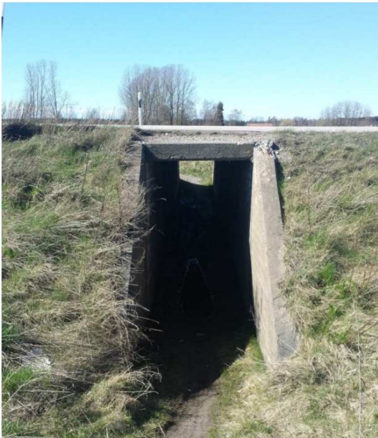
Figur 9 Koport vid Hasslerör, används av barn för att korsa E20 (Samrådshandling - Val av lokaliseringalternativ).
