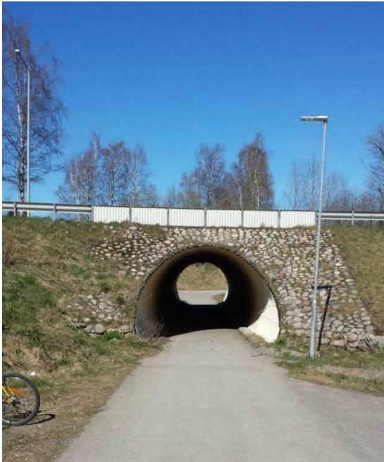
Bild 4.2.3:1 GC-tunnel under E20 norr om serviceanläggningen vid Hasslerör
