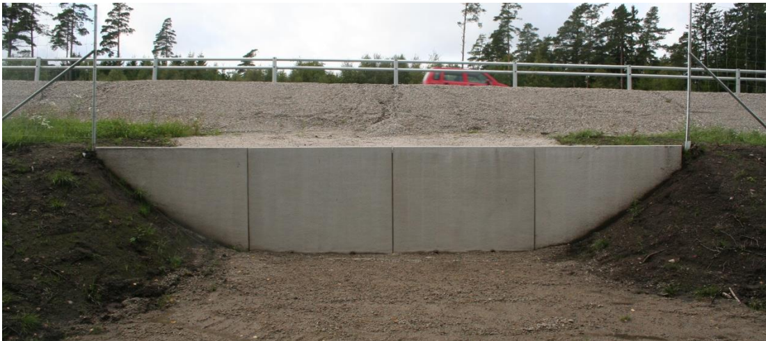
Figur 4.4.1 Viltuthoppens funktion är att medge möjligheter för djur att ta sig ut i naturen igen efter att de har kommit in på fel sida viltstängslet. Viltuthoppets höjd (på bild ca 1,8 m) ska motsvara viltstängslets höjd. Exempel från E6 Tanumshede.
