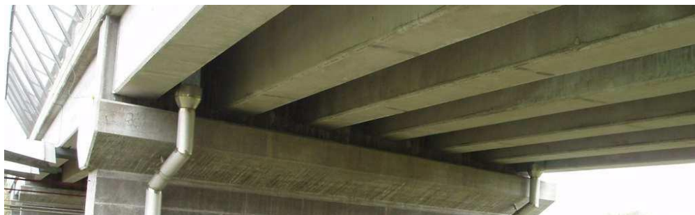
4.3.6.3 Bro med prefabricerade betongbalkar över järnväg norr om Osby. Foto från BaTMan.
