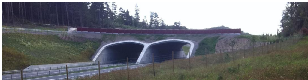
Figur 4.3.6.2 Valvbågar i betong och plåt på E45 norr om Lilla Edet.
