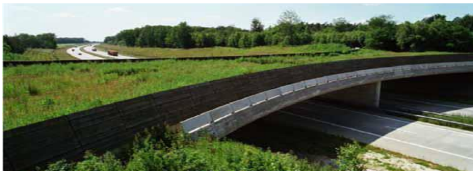
Figur 4.3.1 Exempel på faunabro i betong med faunaskärmar och grönområden.
