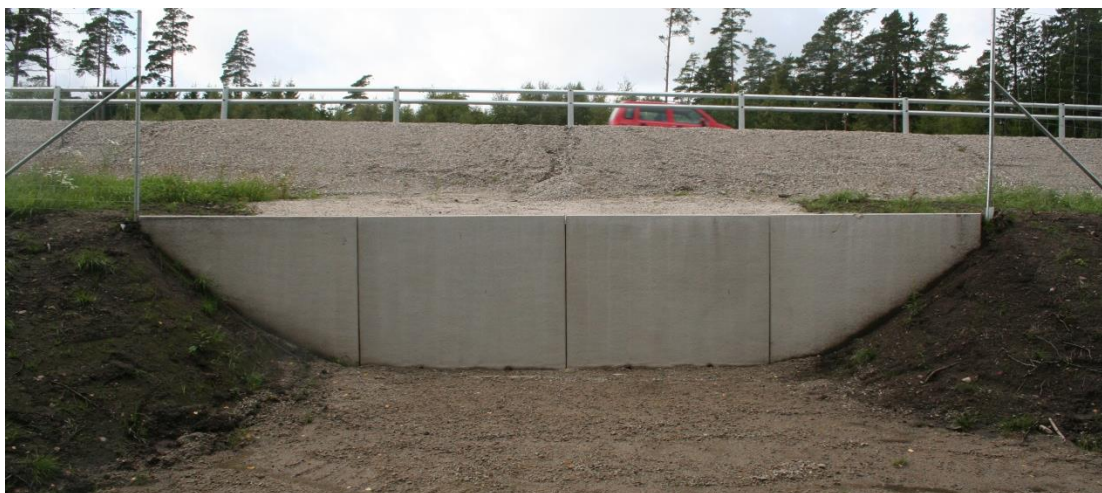
Figur 17. Uthoppens funktion är att medge möjligheter för djur att ta sig ut i naturen igen efter att de har kommit in på fel sida viltstängslet. Uthoppets höjd (på bild ca 1,8 m) ska motsvara viltstängslets höjd. Exempel från E6 Tanumshede.
