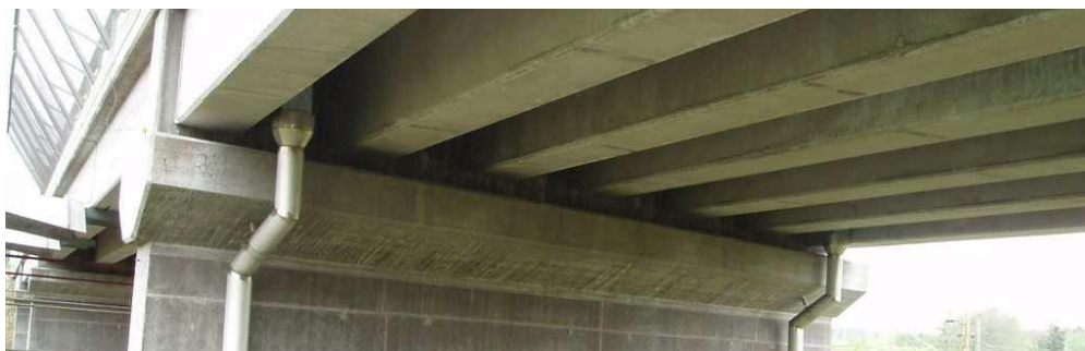
Figur 3. Bro med prefabricerade betongbalkar över järnväg norr om Osby. Foto från BaTMan
