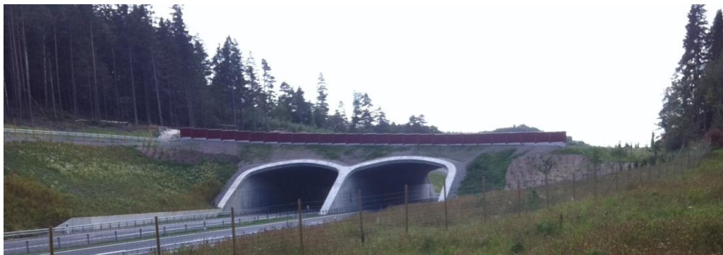
Figur 2. Valvbågar i betong och plåt på E45 norr om Lilla Edet.
