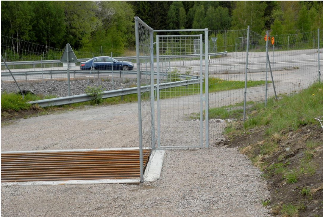
Figur. 4.2.1 Färist vid väg 160, Uddevalla kommun. Gående är här hänvisade till grind intill färisten.
