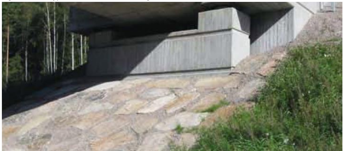
Figur 7.1.1 Ordnad sprängsten under bron utan inramning av kantsten
