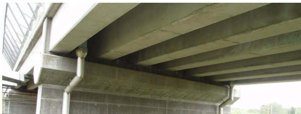
Figur 32. Bro med prefabricerade betongbalkar över järnväg norr om Osby. Foto från BaTMan
