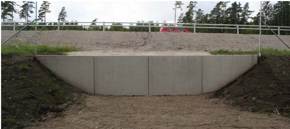
Figur 16. Uthoppens funktion är att medge möjligheter för djur att ta sig ut i naturen igen efter att de har kommit in på fel sida viltstängslet. Uthoppets höjd (på bild ca 1,8 m) ska motsvara viltstängslets höjd. Exempel från E6 Tanumshede.
