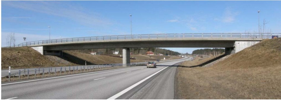
Figur 20. Balkbro över E6 norr om Uddevalla (foto från BatMan)
