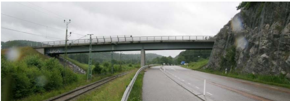
Figur 22. Samverkansbro över Bohusbanan och väg 832 söder om Munkedal. Foto från BaTMan
