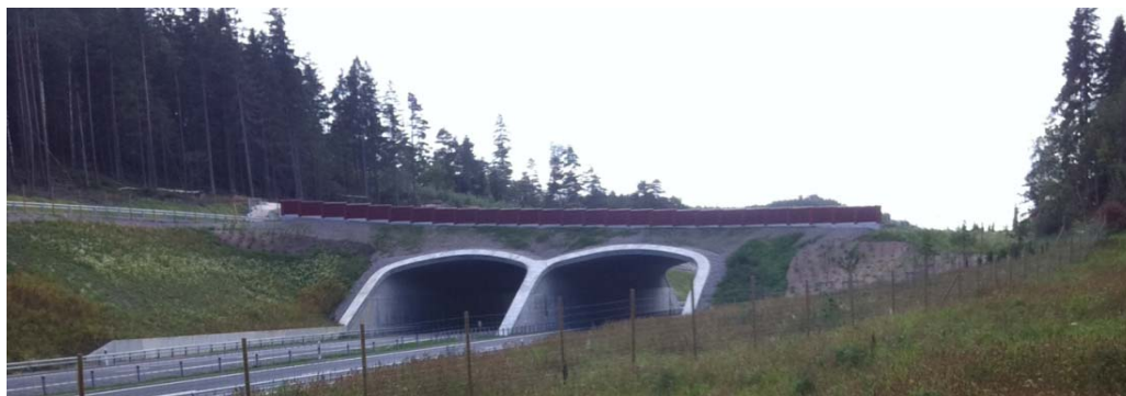
Figur 31. Valvbågar i betong och plåt på E45 norr om Lilla Edet.
