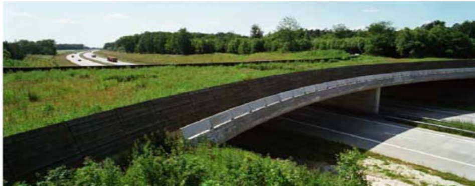
Figur 21. Exempel på faunabro i betong med fauanskärmar och grönområden.
