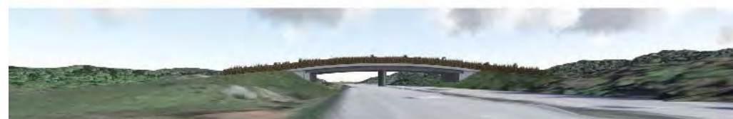
Välvd bro med mittstöd i läge B, fri höjd 6 meter.
