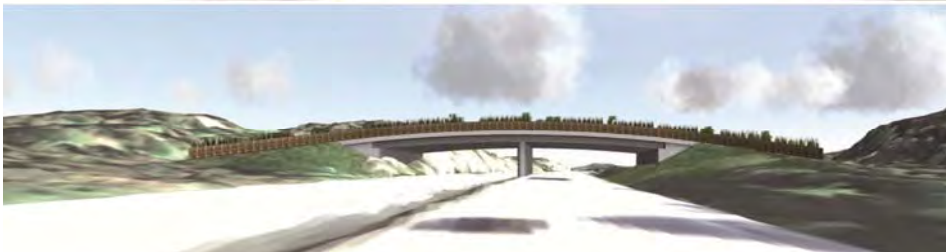
Två olika brotyper i läge C. En bro med trespann, "snedbening" och bro med mittstöd.
