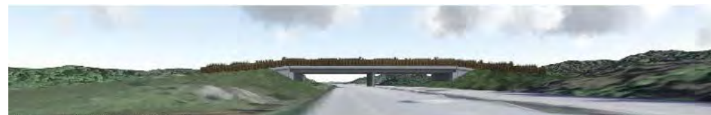
Plan bro med mittstöd i läge B, fri höjd 5 meter.
