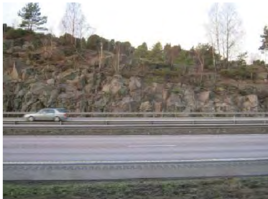
Västra sidans branta, skarpa och kantiga bergsskärningar.
