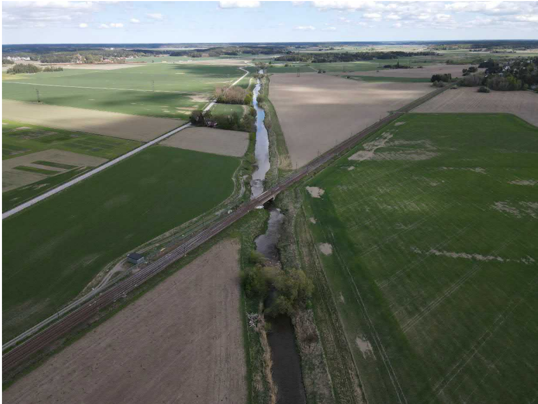
Figur 15 Befintlig järnväg där den korsar Sävjaån (vy mot sydost).
