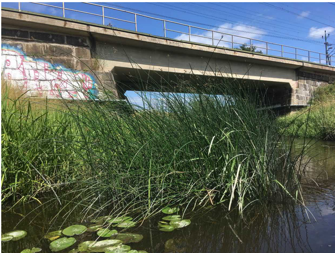
Figur 8 Befintlig järnväg där den korsar Sävjaån (vy från västra sidan av järnvägen mot sydost).
