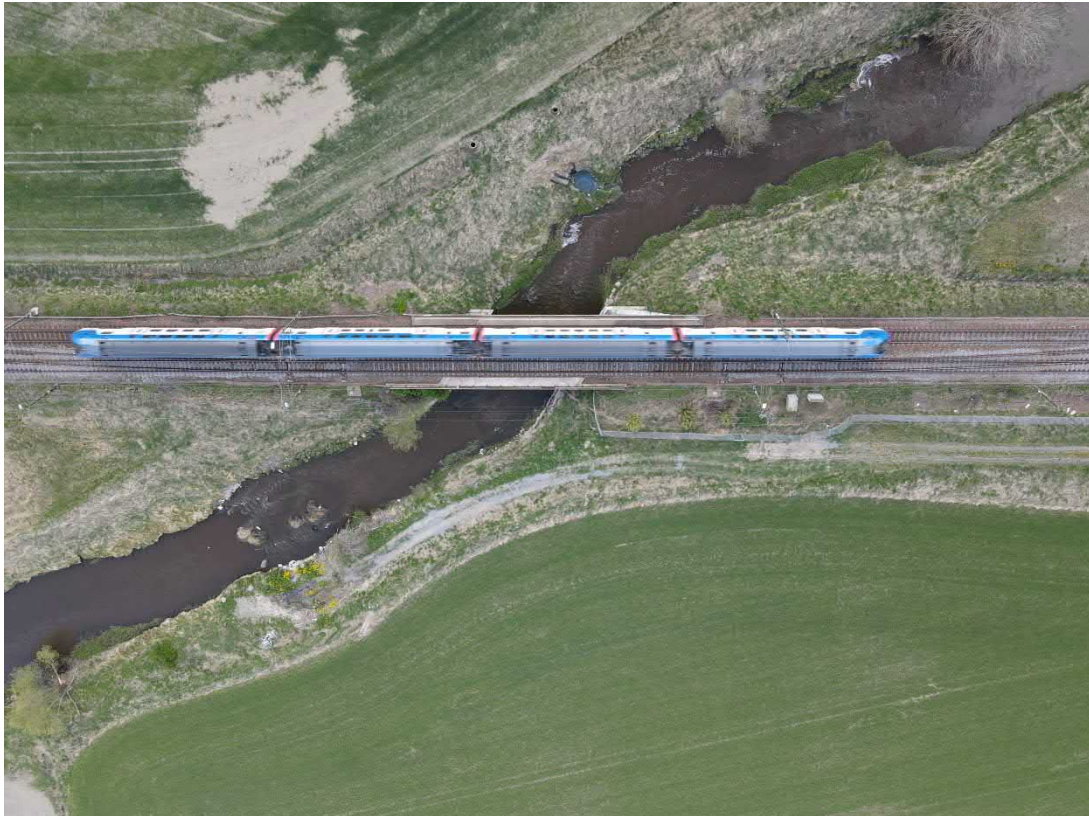
Figur 7 Befintlig järnväg där den korsar Sävjaån (sedd uppifrån, norr mot höger).
