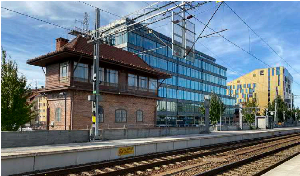
Figur 11. Ställverket (vy mot nordväst).
