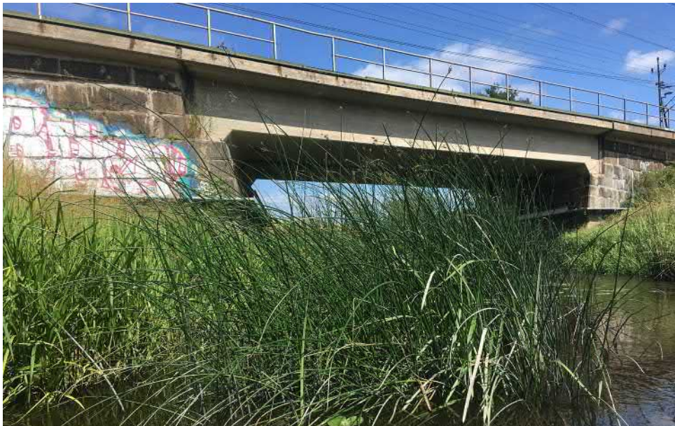
Figur 27. Befintlig bro över Sävjaån.
