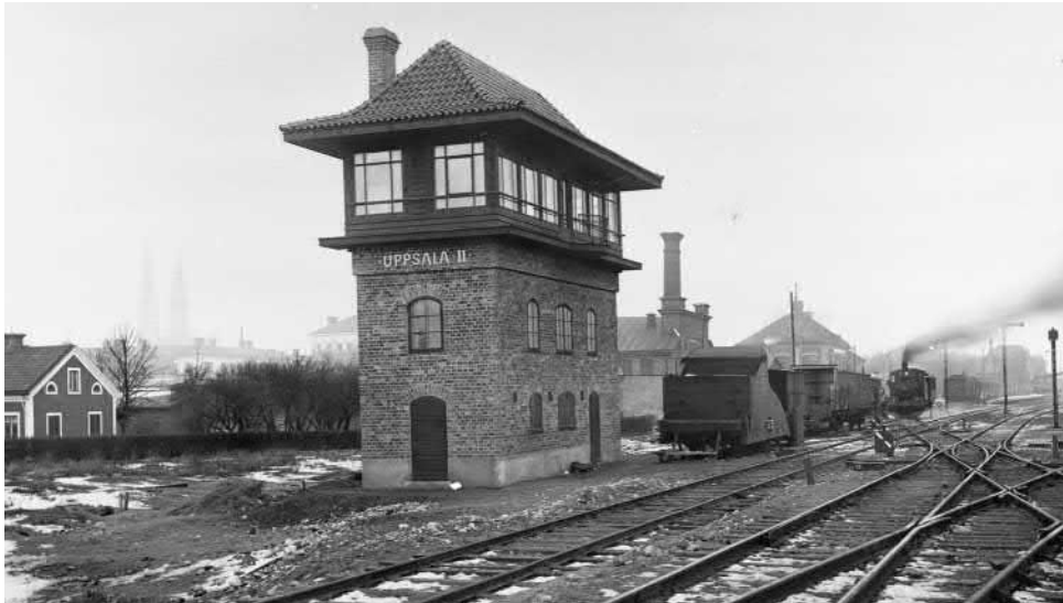
Figur 23. Ställverket vid Uppsala Centralstation.
