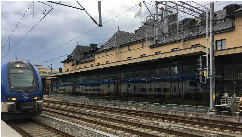
Figur 13. Uppsala centralstation, glasveranda (vy mot sydväst).
