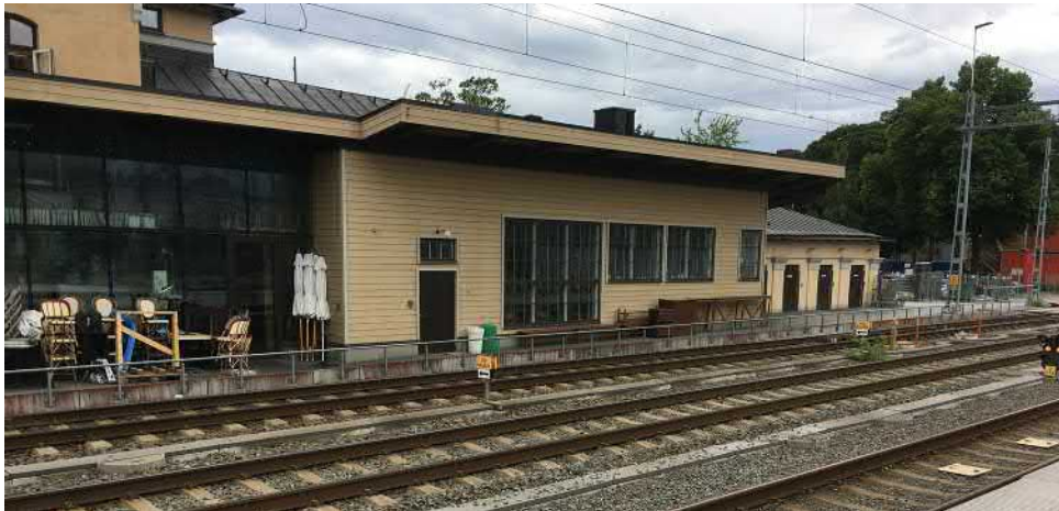
Figur 12. Uppsala centralstation, träfasad (vy mot nordväst).
