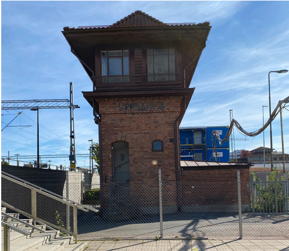
Figur 49 visar en bild på det statliga byggnadsminnet Ställverket.
