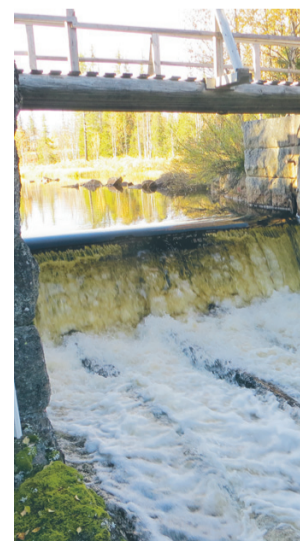
Dammar är vanliga vandringshinder. Byggandet av trösklar underlättar fiskarnas vandring uppströms.
