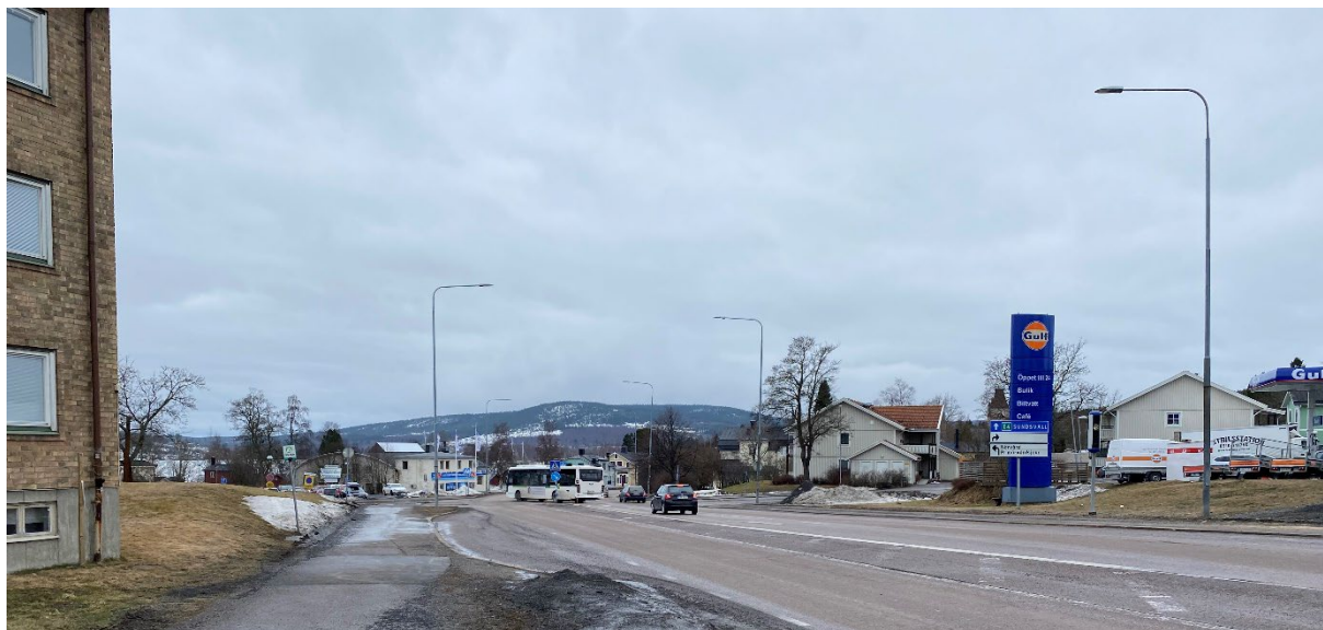
Figur 3:1 Korsningen E4 Södra vägen/Skarpskyttegatan
