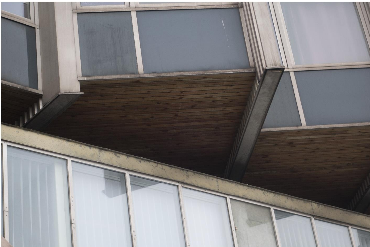
Figur 23: Fasadmaterial i mötet mellan den undre och den övre delen av byggnaden. (Foto WSP 2018-03-07)
