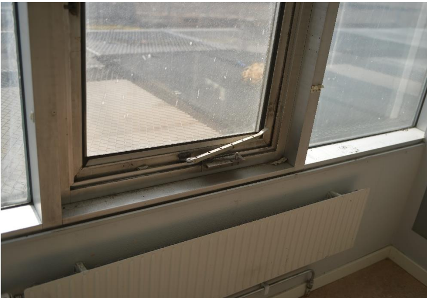
Figur 36: Öppningsbart fönster, plan två. (Foto WSP 2018-04-20)
