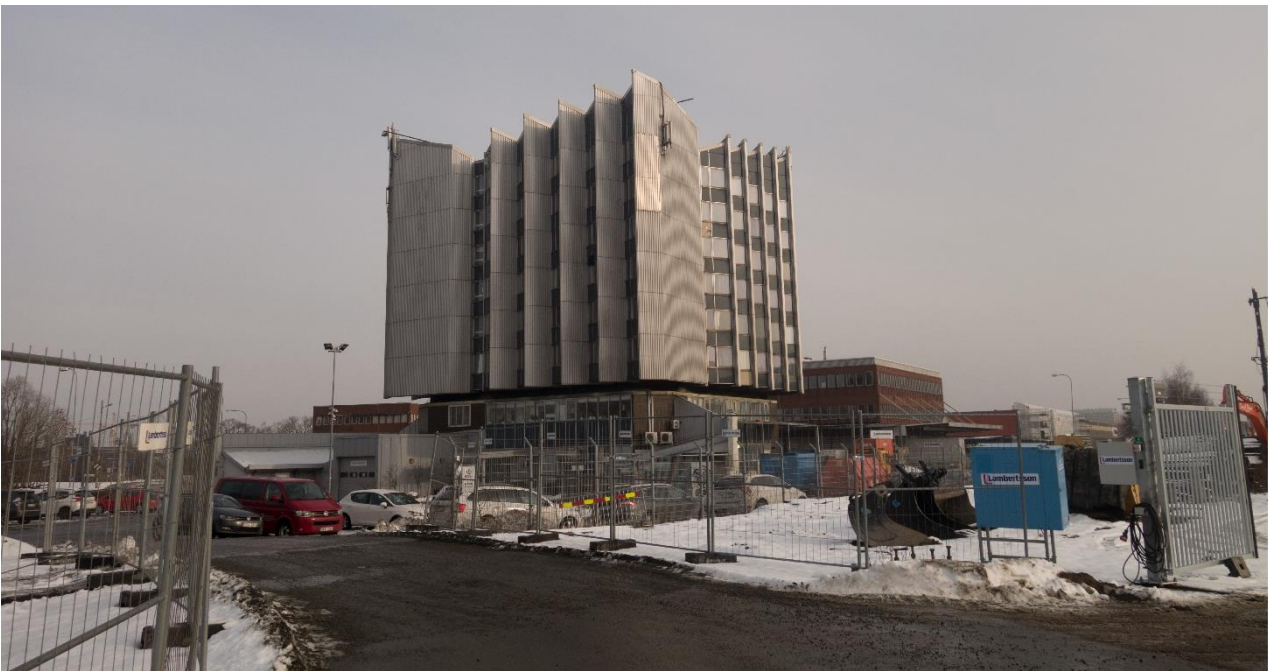
Figur 26: Fasader mot sydväst och sydost. (Foto WSP 2018-03-07)
