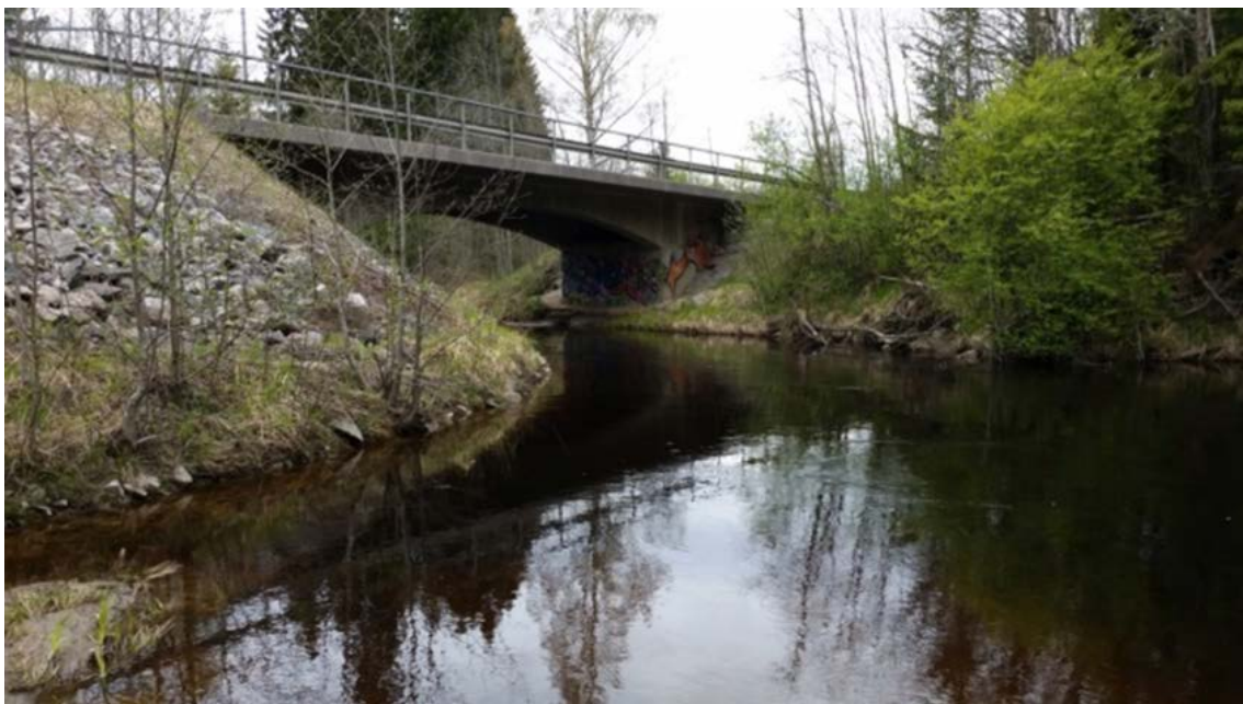
Figur 29. Befintlig bro smalnar av Sättnåån. Ny bro föreslås öster om befintlig bro ungefär där fotot är taget.
