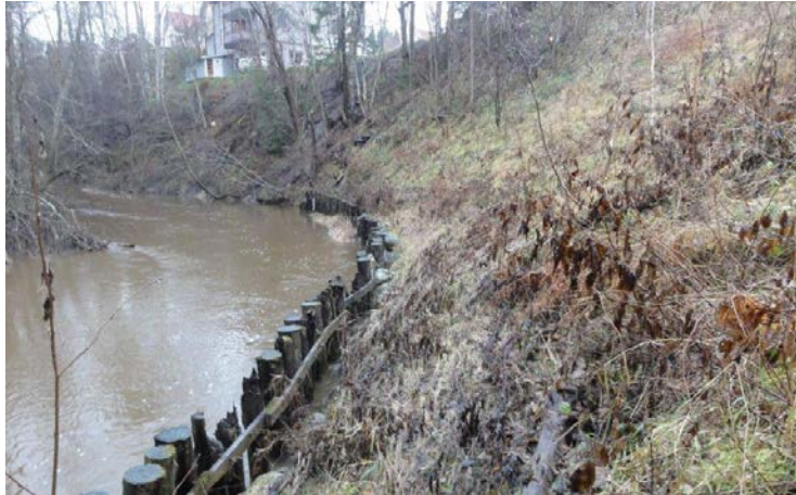
Figur 17. Olika typer av åtgärder såsom träpalissad och förstärkning med geonät har utförts för att förhindra erosion och sättningar i vägbanken. Träpalissaden mot Sättnån fotad mot norr.
