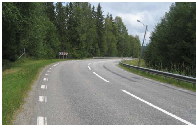
Figur 4. Sidoområde längs väg 86 har flera brister som branta slänter utan räcken och oeftergivliga föremål som träd och belysningsstolpar nära vägen. Flera av belysningsstolparna på den höga vägbanken/höjdryggen längs Sättnån lutar markant. I denna skarpa kurva har flera olyckor skett. Foto mot norr.
