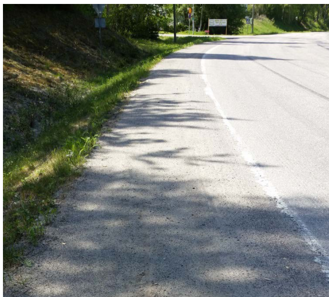
Figur 5. Foto längs väg 320 mot väster. Här finns en bred vägren längs vägens södra sida. Korsning med Viljansvägen/ Åsens väg syns i bakgrunden. Här är skyltad hastighet 50 km/h och trafikmängden ca 1820 ÅDT (fordon per dygn).
