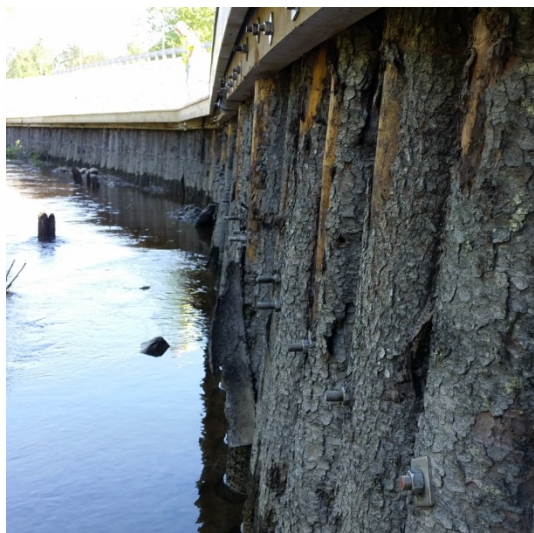
Figur 34. Tänkbar lösning för förstärkning av befintlig träpalissad. Bilden är från tidigare utförda arbeten i Bergsåker.
