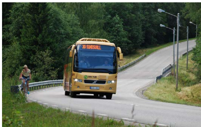
Figur 3. Vägen saknar vägren och utrymmet för oskyddade trafikanter är litet. De snäva kurvorna skapar siktproblem och omöjliggör omkörningar. Flera olyckor har orsakats av vägens undermåliga linjeföring i förhållande till hastigheten. Foto från korsning med väg 629 mot norr längs väg 86.
