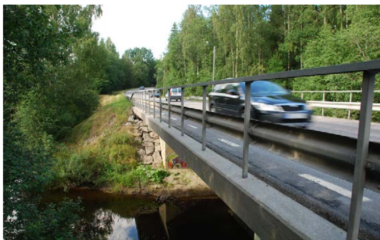
Figur 12. Bron över Sättnaån närmar sig slutet av sin tekniska livslängd men är i gott skick enligt de senaste inspektionerna. Utrymmet för oskyddade trafikanter är mycket litet och utrymme för passage under bron längs Sättnaån är begränsat och omöjliggörs vid högvatten.
