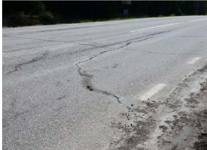
Figur 19. Sprickor i väg 86 norr om Viljansvägens anslutning.
