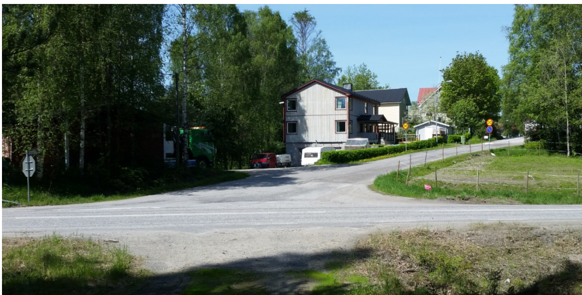
Figur 8. Kommunala Viljansvägens anslutning mot väg 86. Kort vilplan och snäv anslutningsvinkeln tillsammans med lutningen gör att korsningen inte är trafiksäker. Foto från liten skogsbilväg mot väster över väg 86.
