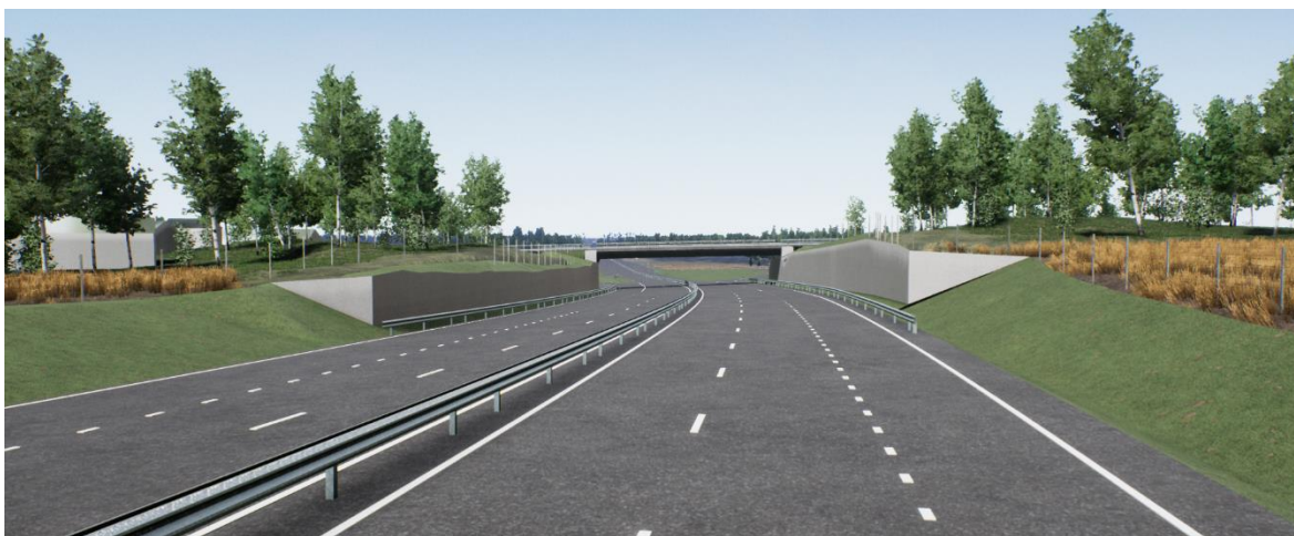
Figur 28. Modell, Varnhemskorsningen sedd från öster med gravfält på båda sidor om vägen. Modellen visar stödmurar mot gravfälten, som kantar underfarten. De föreslås uppföras i kalksten.
