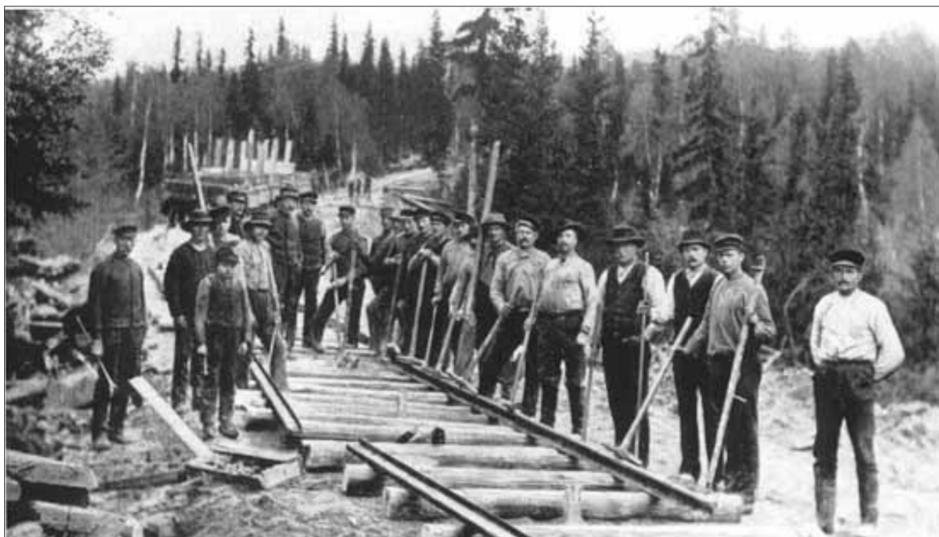
Räsläggarlager vid byggandet av norra stambanan. Bilden är tagen alldeles i närheten av Kohler där de norrifrån och söderifrån kommande räsläggarlagen möttes den 6 december 1893. Foto Sveriges Järnvägsmuseum.
