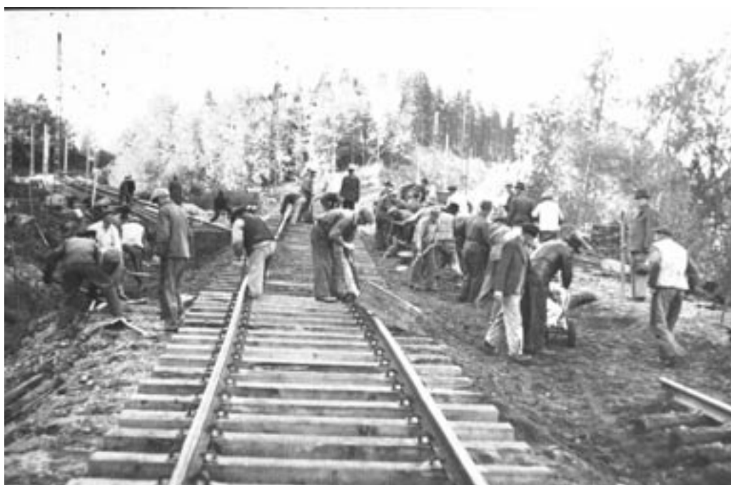
Figur 2.4.1 Rälsläggarglag vid byggandet av norra stambanan. Foto Banverket.
