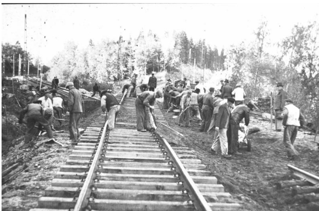
Figur 2.4:1 Rålsläggarlag vid byggandet av norra stambanan. Foto Banverket.
