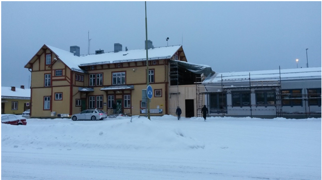
Det gamla stationshuset med påbörjad utbyggnad.
