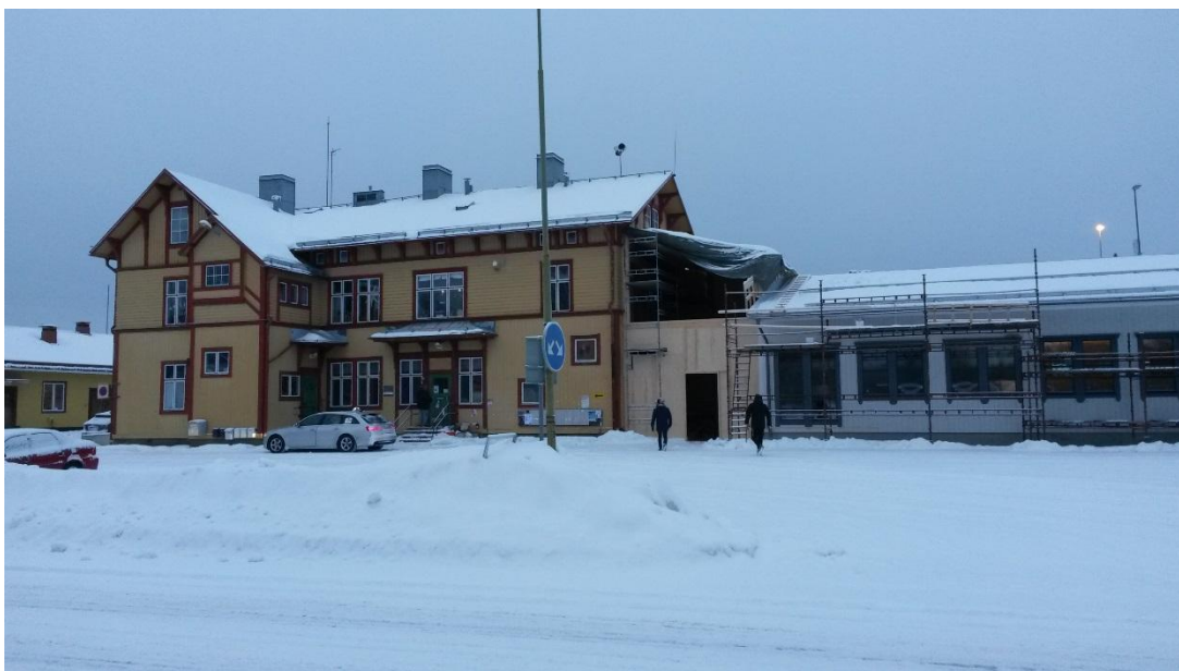
Figur 5. Det gamla stationshuset med påbörjad utbyggnad.
