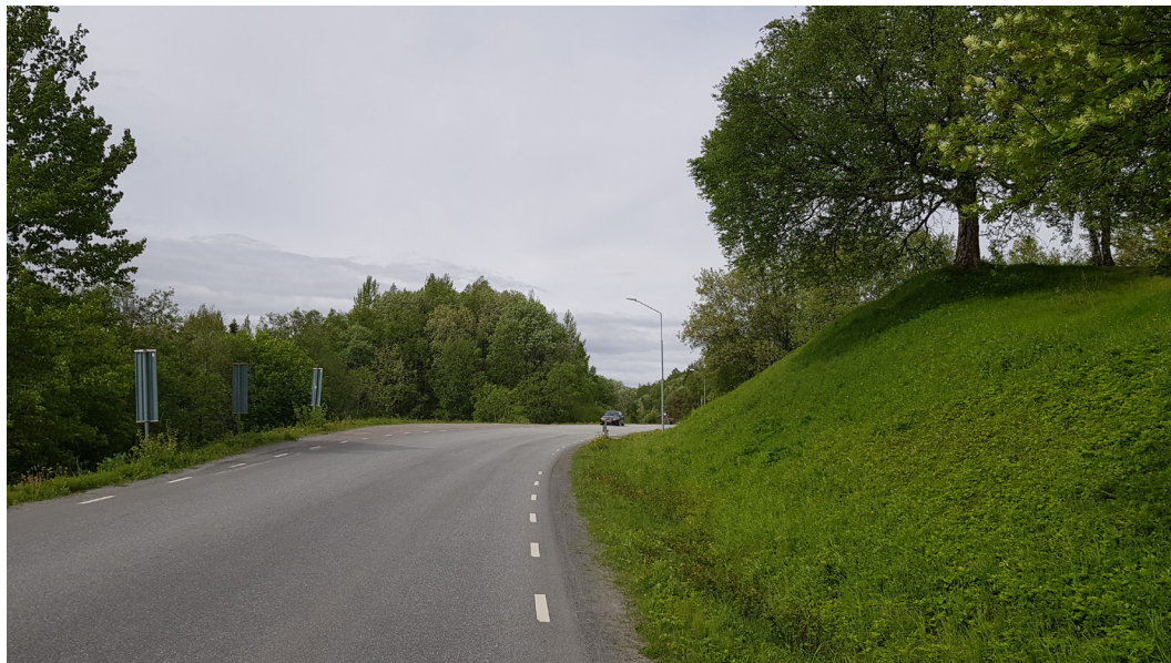
Figur 28. Mur 2 byggs vid en mycket brant slänt på fastigheten Bräcke 1:23 i sektion ca 1/040 – 1/070.
