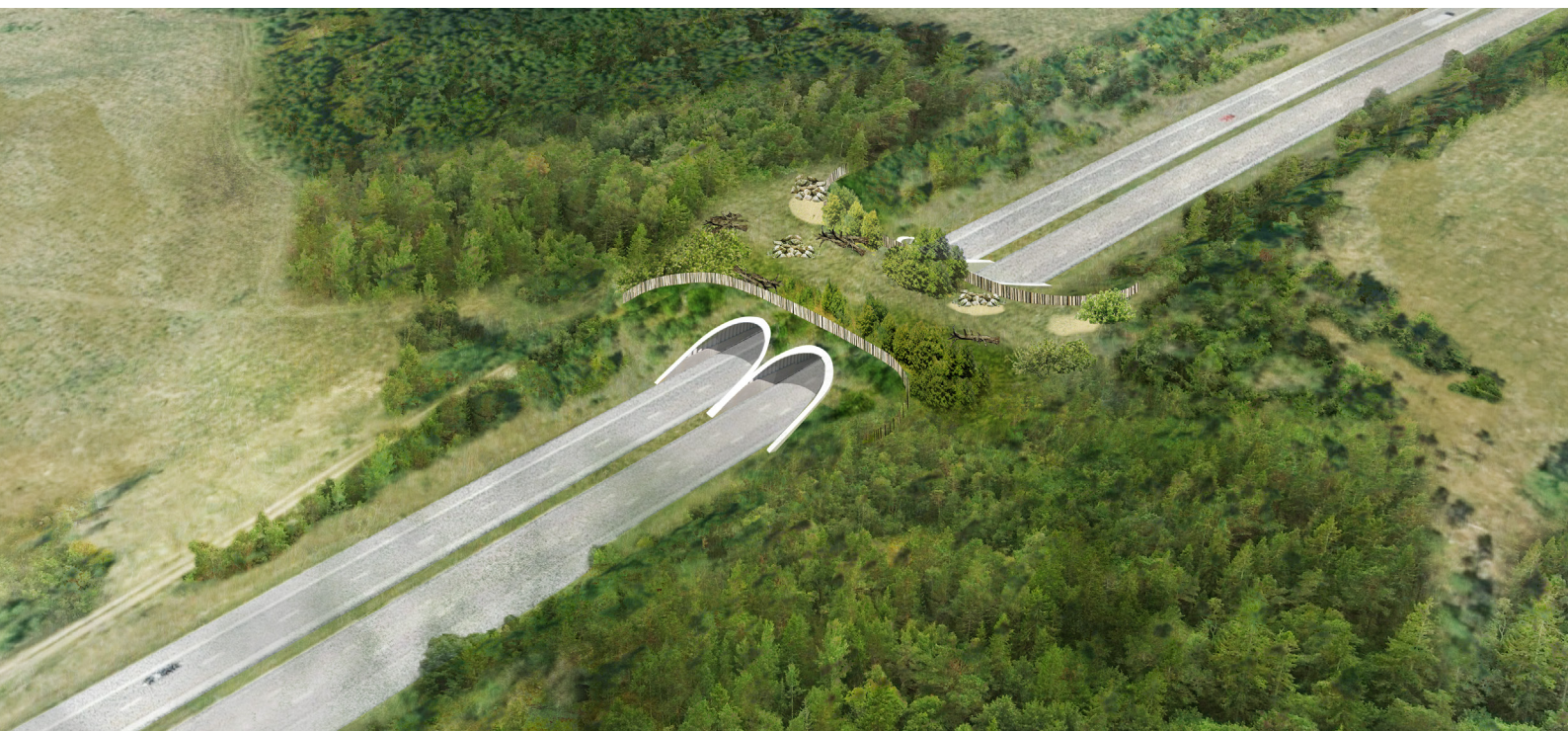
Vy över föreslagen brolösning. Skärmarnas utsträckning syns tydligt längs ekodukten
