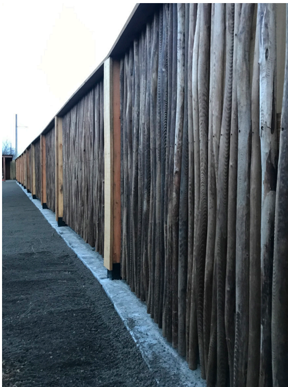
Skärmexempel från Pilebyg (referens i Danmark) med värmebehandlad pil utanpå en tät träskärm.
