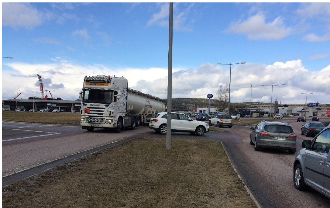
Bild 6. Korsningens utformning såsom den ser ut idag är inte lämplig för den trafikmängd som belastar vägen (Foto: Jenny Lundberg, Sweco).
