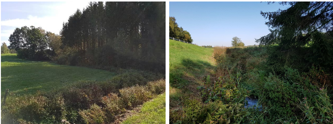
Figur 37. Del av Tormestorpsån (B49) norr om befintlig granplantering som löper längs med väg 23 går förlorad vid kulvertering under ny faunabank. Diket är idag kraftigt igenväxt med ett medelvattendjup på ca 15 cm. Foto t.v. visar delsträcka som berörs, fotot är taget från väg 23 mot sydväst. Foto t.h. visar vattendraget norrut från gränsen mellan åker och granplantering, nedanför bankslänten för väg 23. Fotot taget vid vattendraget i riktning mot norr.
