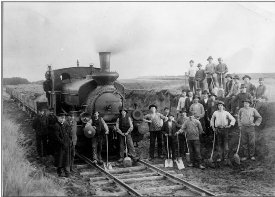
Figur 15 Byggandet av Sölvesborgs-Olofström-Älmhult järnväg omkring år 1900.
