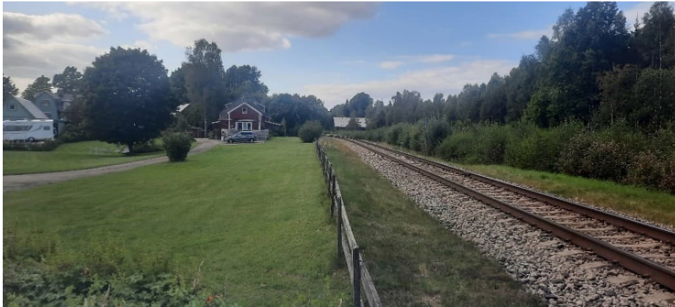
Figur 10 Bebyggelsen ligger mycket nära järnvägsspåret i Långhult.
