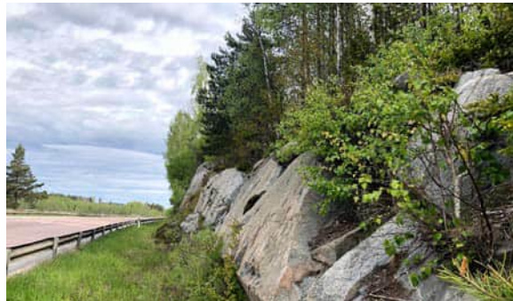
Figur 30. Befintlig bergsskärning längs väg 583.
