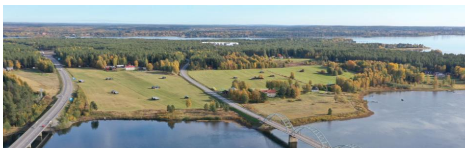
Figur 3. Flygfoto över Lule älvs norra strand de båda vägbroarna och odlingslandskapet med sina lador.
